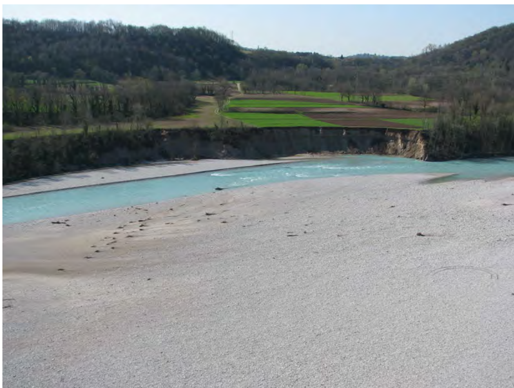
Figura 30: erosione IV in sponda sinistra.
