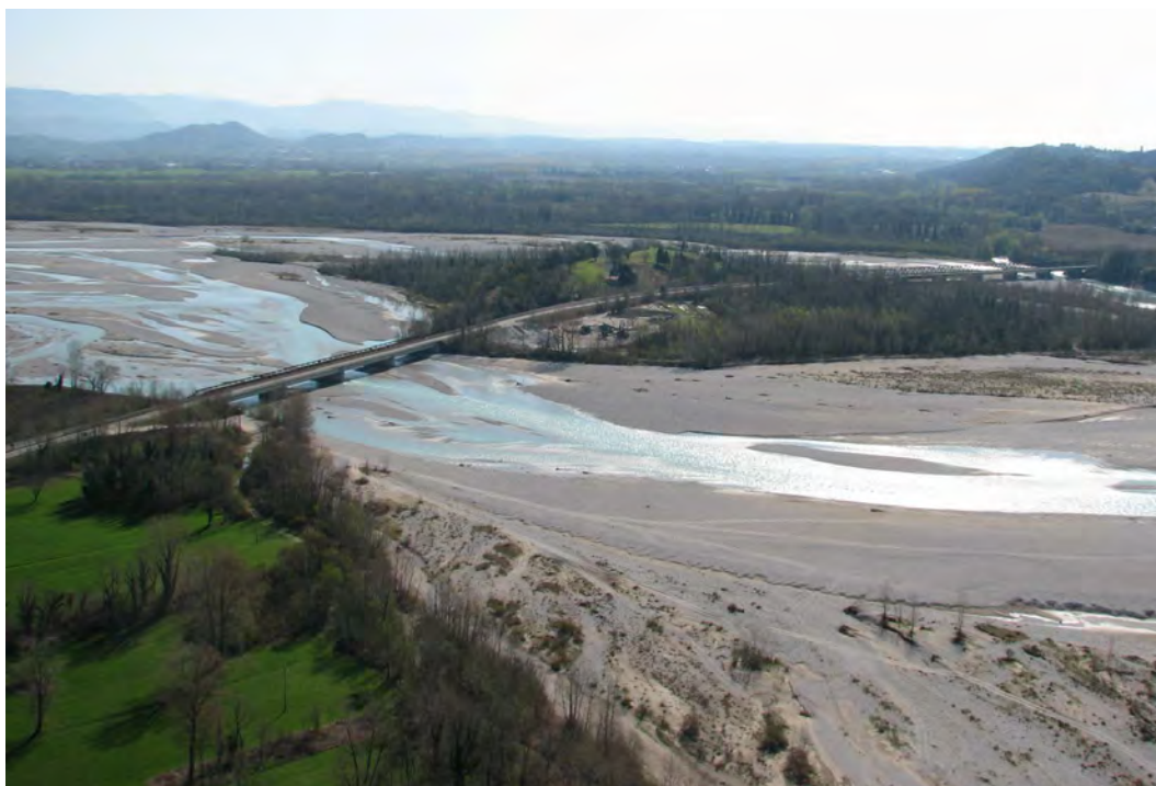
Figura 28: il ponte di Cornino-Cimano
