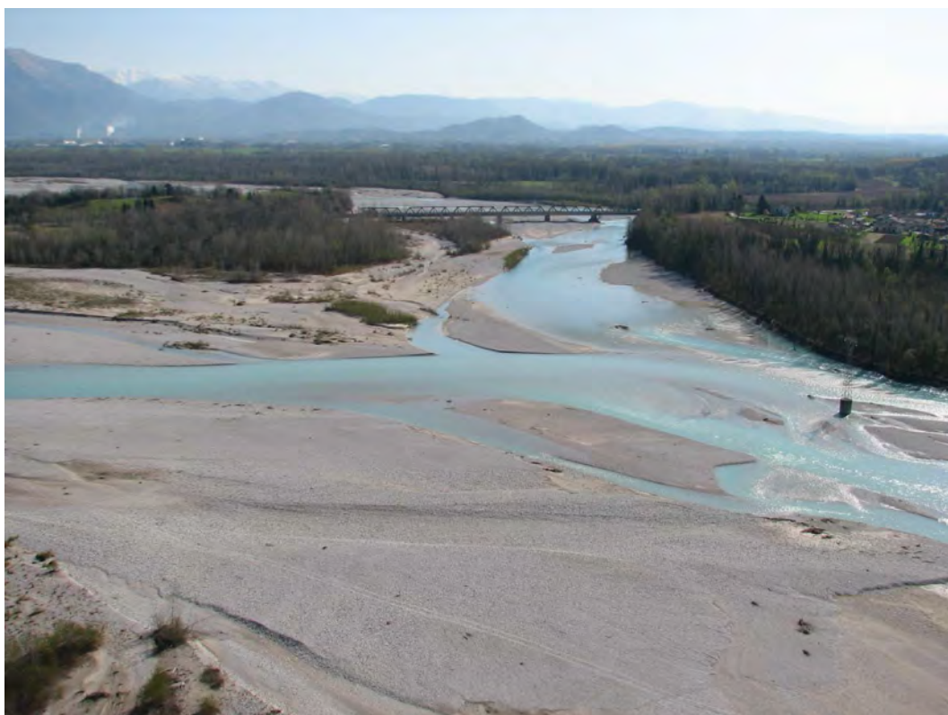
Figura 22: vista verso monte del ponte e dell'isola Cornino-Cimano.
