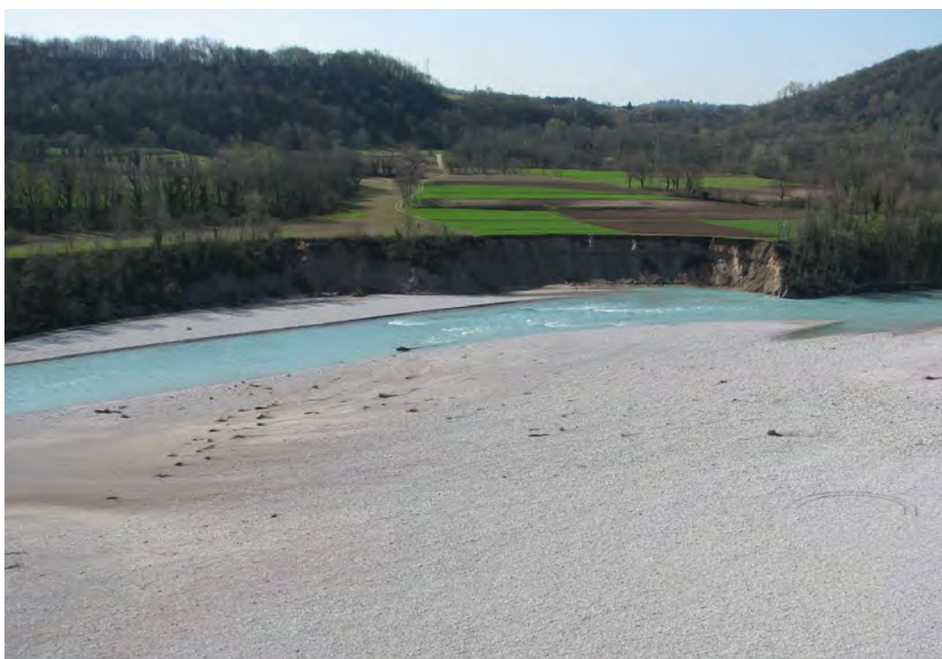
Figura 23: evidente erosione in sponda sinistra a valle del ponte Cornino-Cimano. L'arretramento della sponda negli ultimi 20 anni è stato di oltre 160 metri! L'alveo ora interessa superfici poco tempo fa occupate da una rigogliosa foresta ripariale e da aree agricole. L'intervento in oggetto intende ripristinare e fermare mediante difesa spondale tale incisione.
