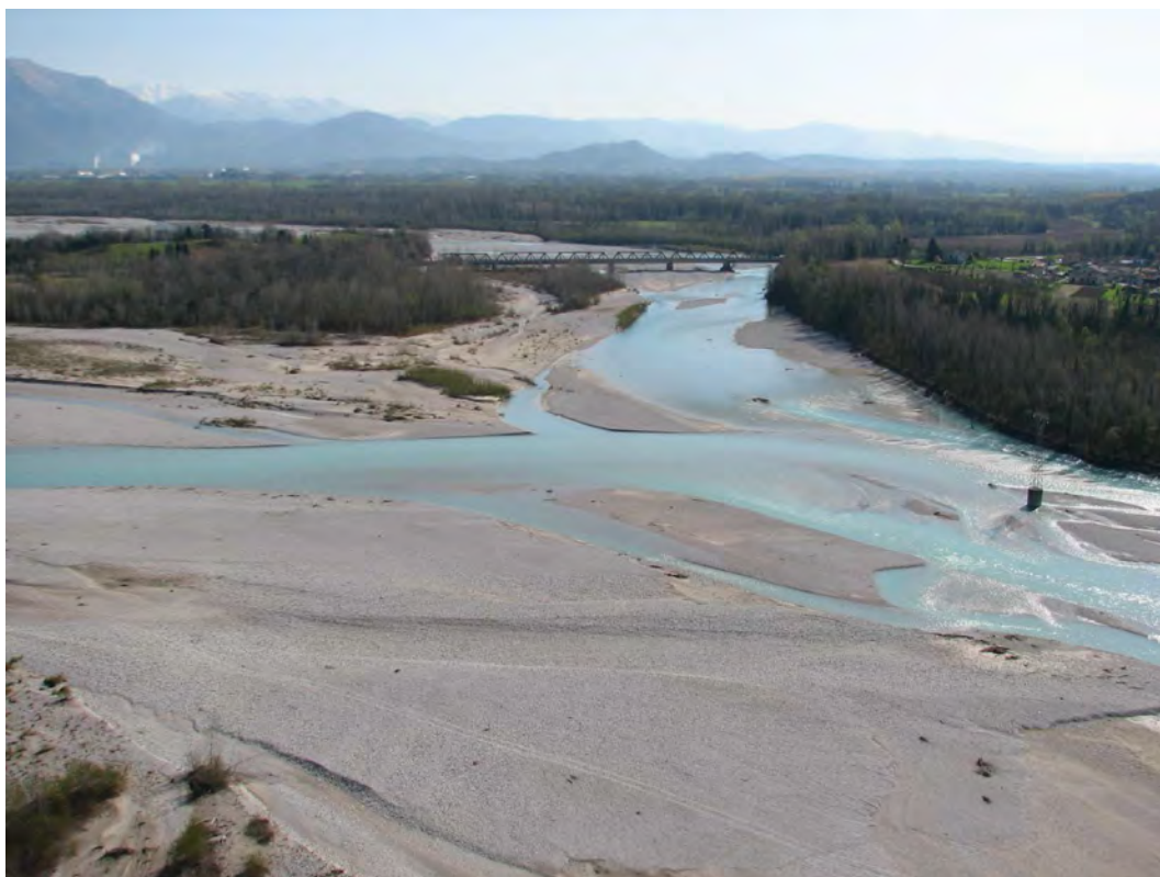
Figura 29: il ponte di Cornino-Cimano, sponda sinistra (verso monte).
